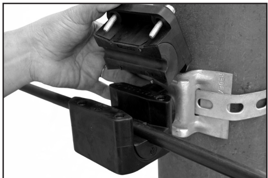
Foto 5 – Posicionando o coxim no corpo do FDS.
