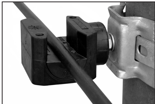
Foto 4 – Colocando o cabo no berço do coxim.
