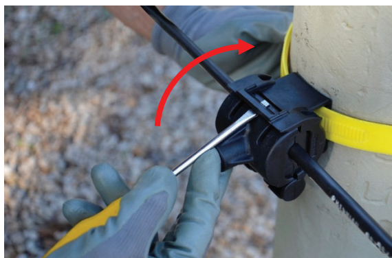
Instalação com Cinta Dielétrica ou Fita de Aço
