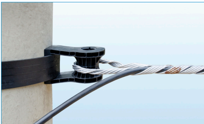
Ancoragem com alça preformada
