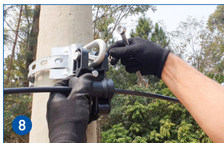
8 Finalize a fixação travando o pino com a presilha.
