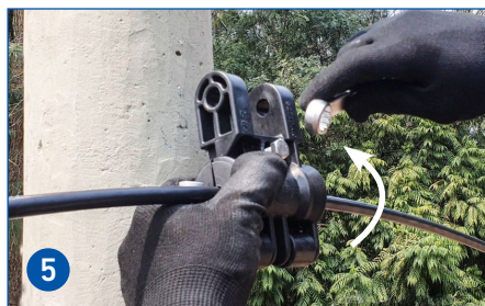
5 Reaperte o parafuso cativo com a chave apropriada para fechar o grampo.
