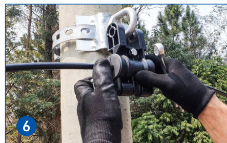
6 Posicione o grampo no olhal do suporte.
