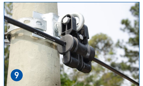
9 Grapa de Suspensión Fiberlign totalmente instalada.
