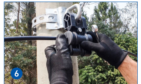
6 Posicione la grapa en el ojal del soporte.
