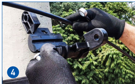
4 Posicione el cable sobre la cuna del inserto y cierre la grapa.
