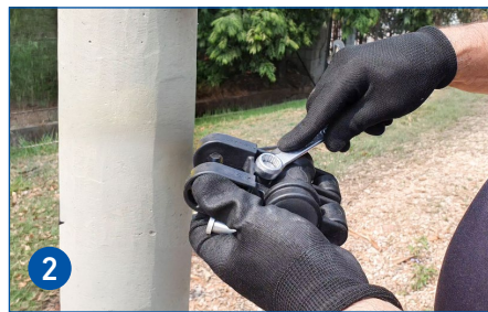
2 Utilizando una llave adecuada, afloje el tornillo cautivo sin retirarlo del cuerpo de la grapa.
