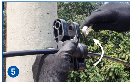
5 Vuelva a apretar el tornillo cautivo con la llave adecuada para cerrar la grapa.
