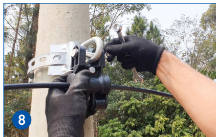
8 Finalice la fijación asegurando el pasador con la presilla.
