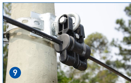
9 Grampo de Suspensão Fiberlign totalmente aplicado.
