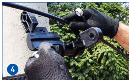
4 Posicione o cabo sobre o berço do inserto e feche o grampo.
