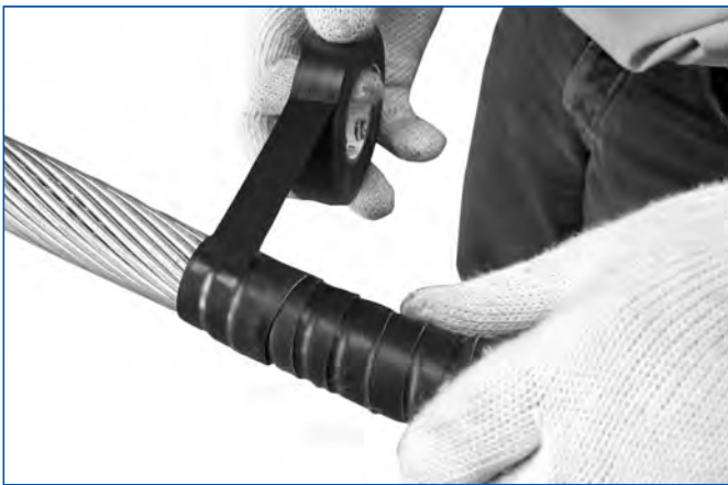
7. Aplique uma camada de fita isolante sobre a extremidade da fita de bandagem.
