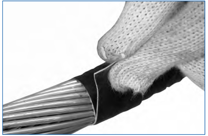
6. Posicione a ponta da fita rente a camada da fita aplicada.
