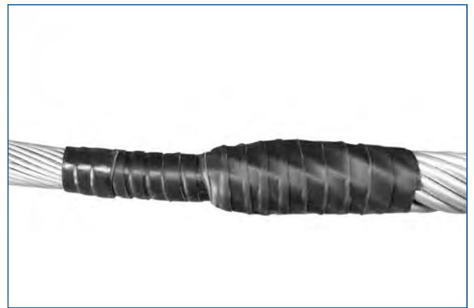
8. Fita de bandagem totalmente aplicada sobre a extremidade da Emenda Total Preformada e do Condutor.
