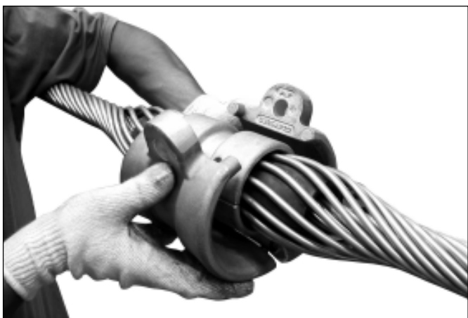
10. Posicione as sapatas externas sobre as sapatas internas, com os furos do parafuso voltados para cima.
