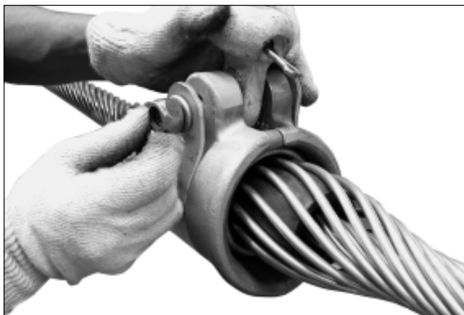
12. Posicione a conha olhal entre as orelhas das sapatas externas e insira o parafuso, a arruela e a porca.
