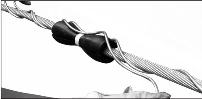
**5.** Coloque el resto de las varillas con espacios iguales entre ellas. **NO TUERZA, CRUCE NI DEFORME LAS VARILLAS.**
