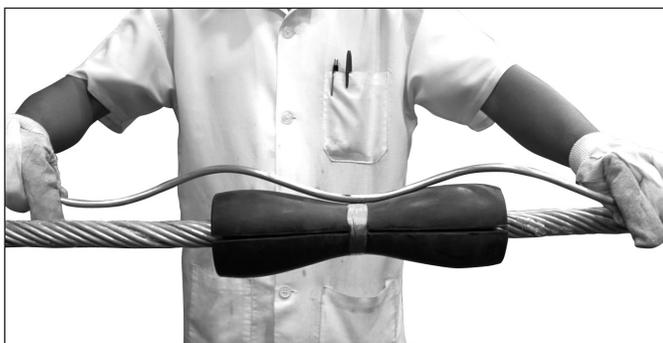
**3.** Centre la primer varilla de la Grapa de Suspensión en el manguito con la marca de color hacia fuera y enróllela sobre el manguito. Aplique el largo suficiente de la varilla para asegurar la estabilidad del conjunto, dejando cerca de 30 cm. libres en ambos extremos.
