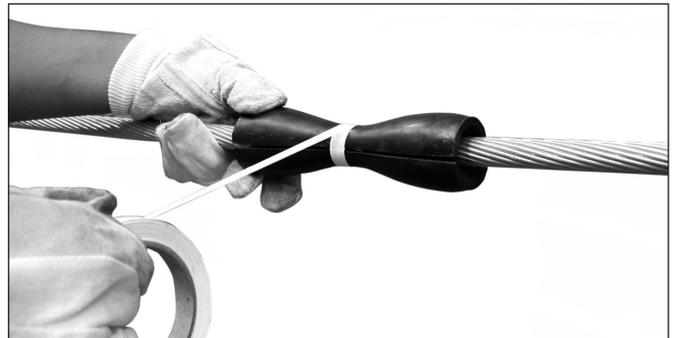
**2.** Sobre la marca indicada coloque los manguitos fijando las dos partes con una capa de cinta adhesiva fina.
