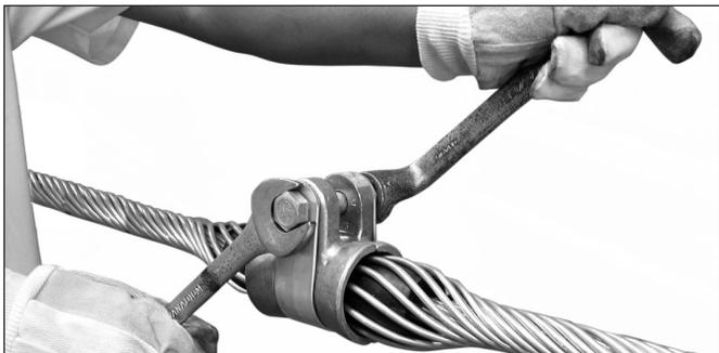
**9** Introduzca el tornillo a través de la abrazadera y de la zapata. Coloque la arandela de presión y la tuerca autofrenante. Apriete hasta que la arandela de presión quede casi plana.
