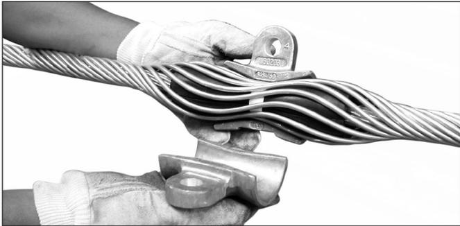
**7.** Posicione la zapata de la Grapa en ambos lados del manguito de neoprene con el agujero para el tornillo mirando hacia arriba.
