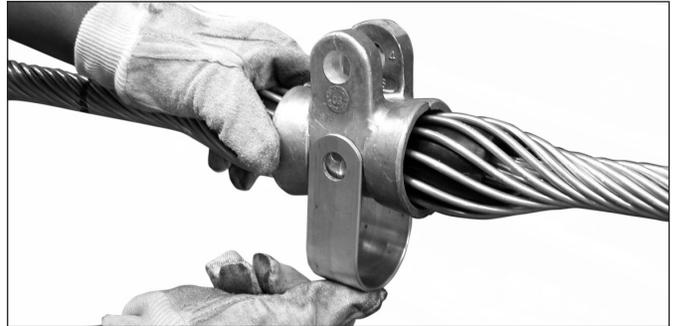
**8.** Deslice la abrazadera para que quede posicionada sobre la zapata. Separe las orejas de la zapata y empuje nuevamente la abrazadera a su posición. Esto asegurará que el tornillo pueda ser fácilmente insertado.
