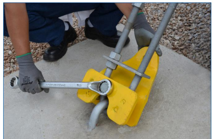
**4.** Insira o parafuso no Dispositivo e aperte-o com uma chave de boca.
