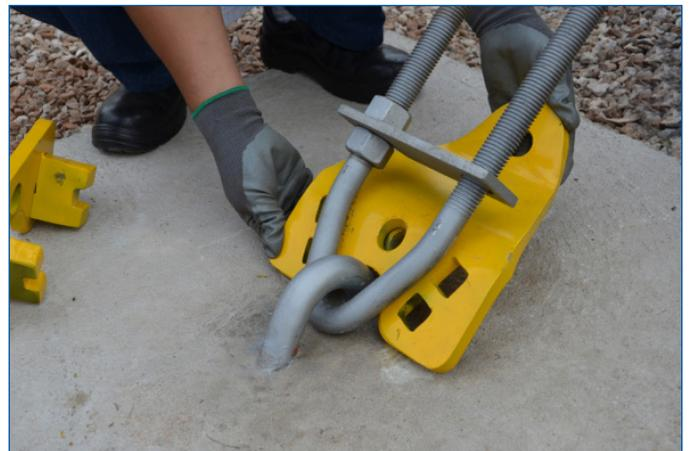
**2.** Posicione a Base A do Dispositivo no lado inferior do Grampo "V" do Vari-Grip.
