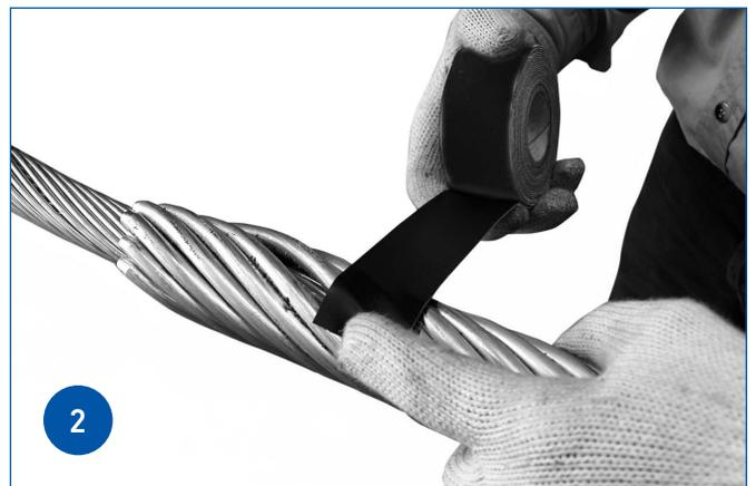
Posicione a fita de bandagem sobre a marca feita na Emenda Preformada e inicie a aplicação.
