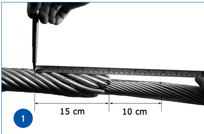
Meça o comprimento onde será aplicada a fita de bandagem sobre a Emenda Preformada e o cabo, obedecendo as medidas acima.
