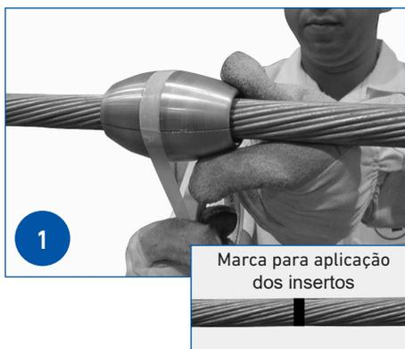
Assinale a posição correta do Grampo sobre o cabo e aplique os insertos fixando as metades com uma camada de fita adesiva.
