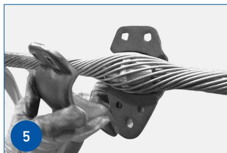
Posicione as sapatas em ambos os lados dos insertos com os furos centrais voltados para baixo.
