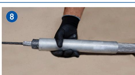
Insira a luva interna do grampo no condutor, deixando-a alinhada na extremidade dos fios externos de alumínio.
