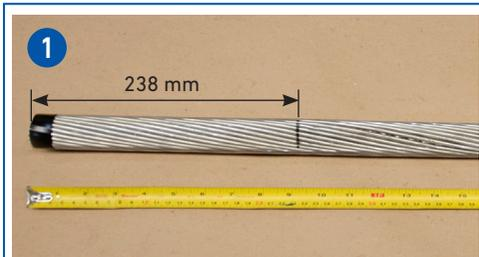
Meça e marque 238 mm (9,37") a partir da extremidade do condutor. Aplique a fita logo após a marca para prender os fios externos durante o procedimento de corte no Passo 2.
