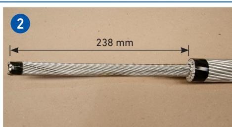
Com uma ferramenta de corte de condutor, remova as duas primeiras camadas dos fios externos de alumínio, até a marca de 238 mm (9,37").
