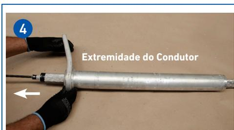
Deslize o grampo de alumínio sobre o condutor até passar pela marca feita no Passo 1. A base de derivação jumper deve ser orientada em direção à extremidade do condutor.
