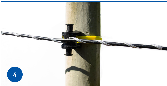
4 Lazo Preformado completamente aplicado.
