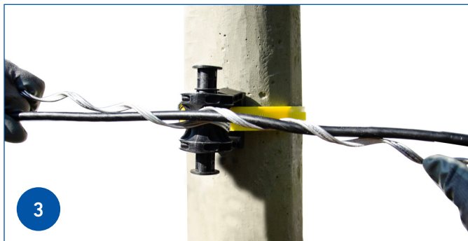
3 Tire de las patas del lazo en direcciones opuestas y aplique primero una pata sobre el cable, luego la otra.
