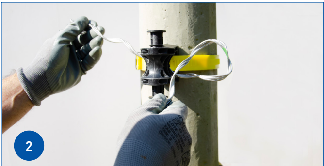
2 Introduzca el Lazo Preformado en el SIPA y coloque el conductor entre las patas del lazo.
