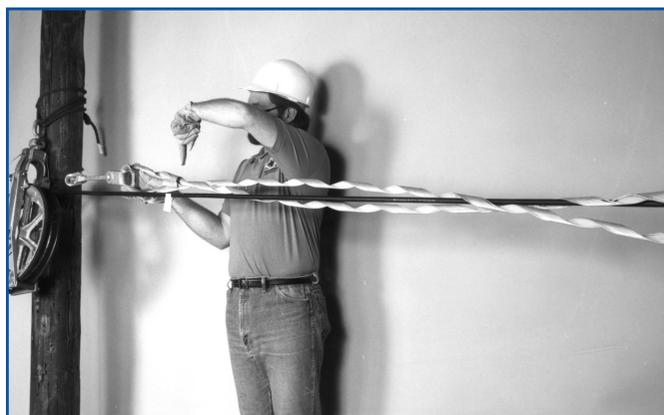
Figura 2 - Posicionamento da Alça Preformada.
