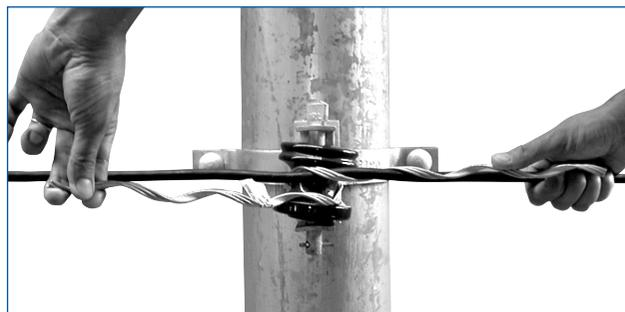
2. Puxe as pernas do Laço Preformado em direções opostas. Inicie a aplicação de uma das pernas do Laço envolvendo-a sobre o cabo.
