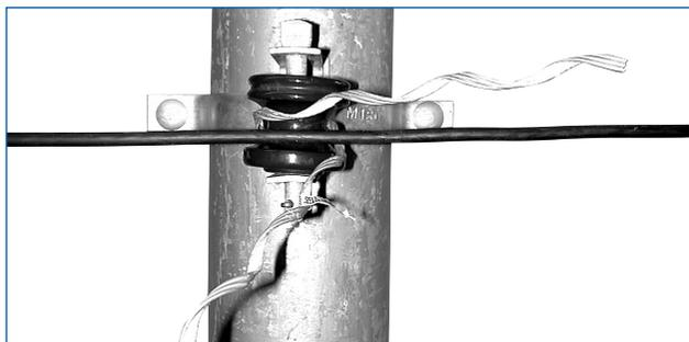
1. Posicione o Laço Preformado no isolador roldana. O cabo deverá ficar entre as pernas do Laço Preformado.
