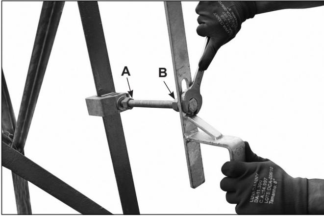
5. Com um torquímetro chave de boca aplique um torque de 3,0 kgf.m na cabeça do parafuso.
