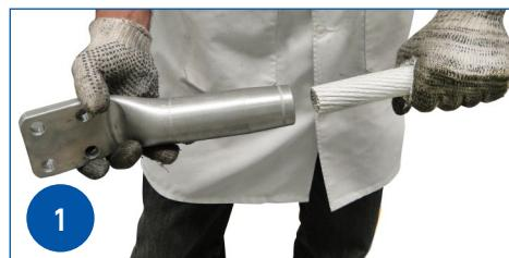
Para aplicar a derivação, escove a superfície do cabo, aplique pasta antióxido na extensão do comprimento da peça e introduza o cabo no interior da derivação.
