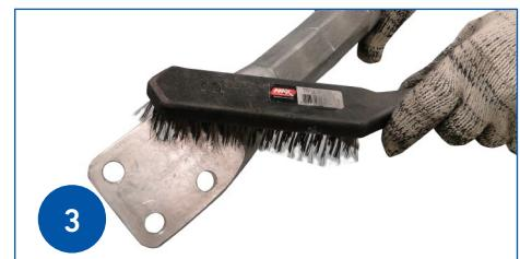
Com uma escova de aço, limpe as superfícies da lingueta do grampo e da derivação que ficarão em contato.
