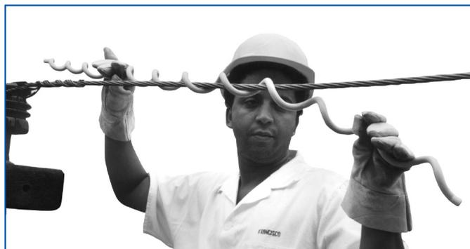
**2.** Inicie a aplicação do SVD em direção contrária ao acessório de fixação, como mostra a foto.
