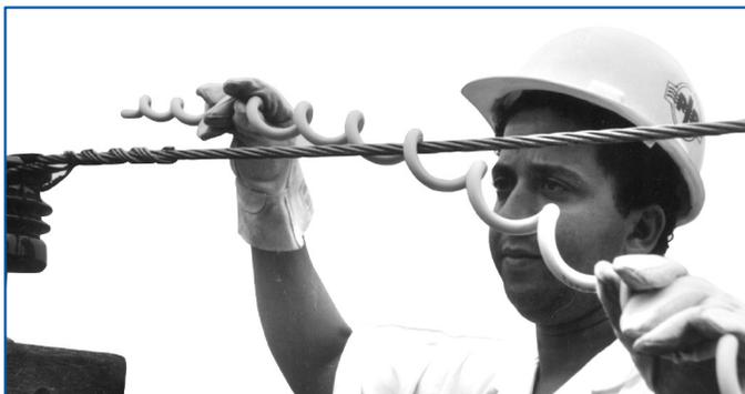
**1.** Posicione o SVD deixando a região de agarramento voltada para o acessório de fixação do cabo (ancoragem, suspensão ou amarração).
