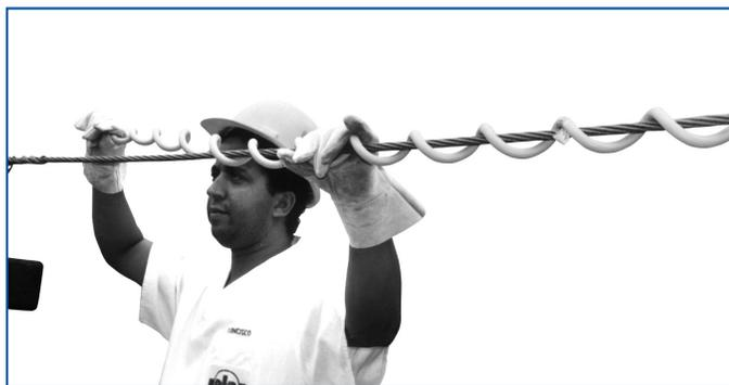
**3.** Aplique primeiramente a região de amortecimento do SVD deslizando-a sobre o condutor, de modo a deixar uma distância de 10 cm entre o acessório de fixação e o SVD.
