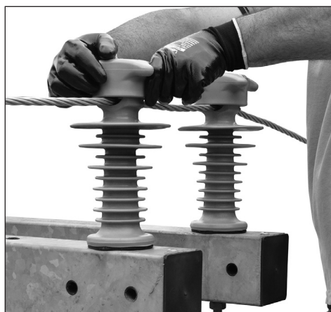
2.4 Finalize a aplicação com as duas mãos para o travamento total da porca e do cabo.
