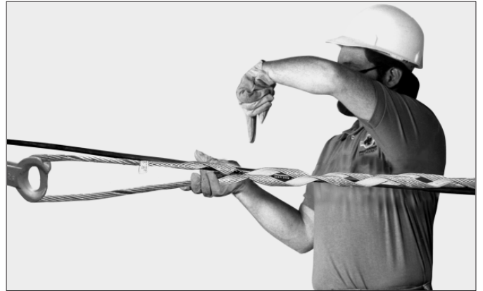
Figura 2 - Posicionamento da Alça Preformada.
