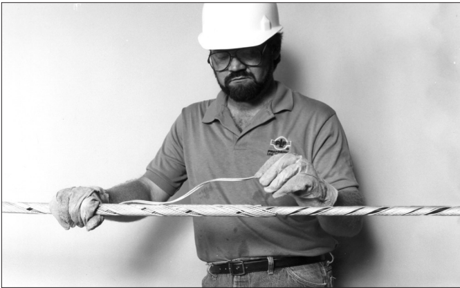
Figura 10 - Separando as varetas da perna da Alça Preformada.
