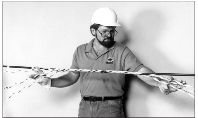
Figura 7 - Completando a aplicação do SRR.
