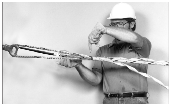
Figura 8 - Comece a aplicação pelo cruzamento de marca do código de cor.
