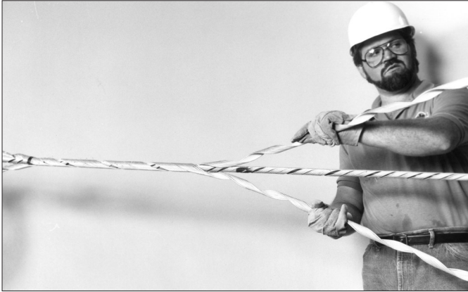
Figura 9 - Envolvendo a Alça Preformada.
