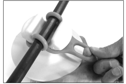
4.3 Puxe levemente o Anel e encaixe-o no pescoço do Isolador.
