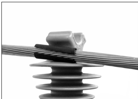
3.1 Aplique o coxim no condutor. A abertura do coxim deverá ficar para fora, conforme indicado.
