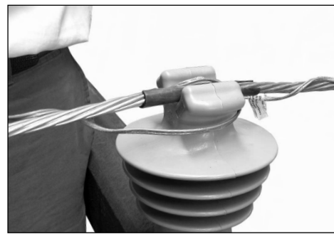
2.3 Gire o Laço 180°, passando suas pernas por baixo do condutor e encaixando-as no pescoço do isolador até que elas fiquem novamente paralelas ao condutor.
