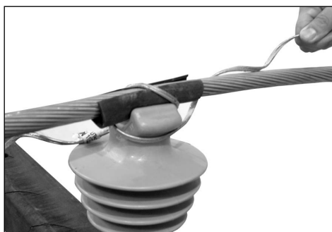
2.4 Agora, simplesmente aplique uma perna do Laço no mesmo sentido de encordoamento do condutor.
