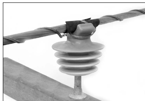
2.6 Laço Preformado de Topo aplicado.
