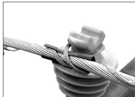
3.3 Puxe as pernas do Laço Lateral em direções opostas e enrole-as sobre o condutor. Certifique-se de que o Laço seja aplicado com o mesmo sentido de encordoamento do condutor.
