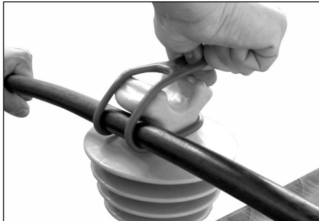
5.2 Encaixe um dos lados do Anel no Isolador e puxe levemente a outra ponta até conseguir encaixá-la no pescoço do Isolador.
