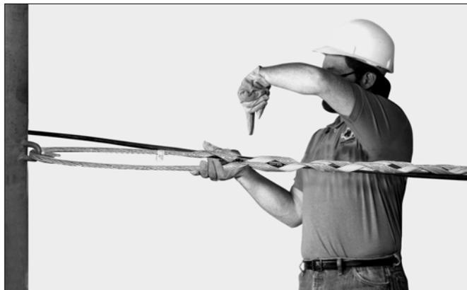
Figura 2 - Posicionamento da Alça Preformada.
