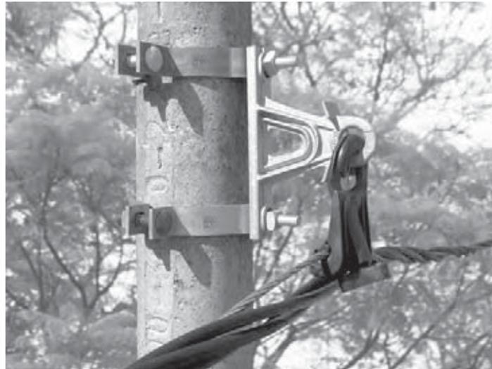
O Conjunto Grampo de Suspensão Multiplex - GSE destina-se à suspensão de cabos multiplexados em redes secundárias ou primárias até 25 kV.
