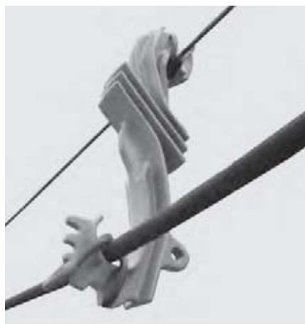
Acessório de formato reto desenvolvido especialmente para utilização em Redes Compactas Rurais Monofásicas classe de tensão 15 kV. Apoiado sobre um cabo mensageiro, sua função é a sustentação do cabo fase coberto ao longo do vão, mantendo o isolamento elétrico da rede.
