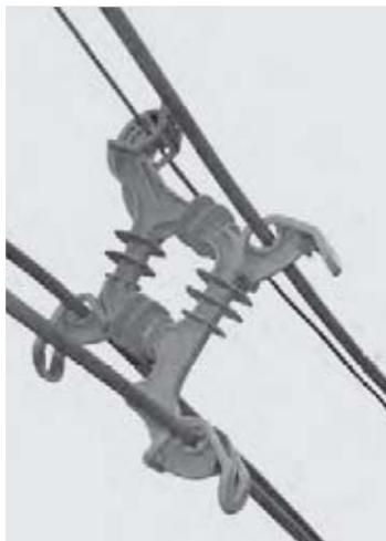
O Espaçador Polimérico com Garras é usado em Redes Compactas, classe de tensão 15 kV, em cabos cobertos.
