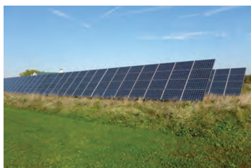
Utilitários - Montagem em Solo
