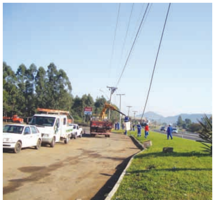
Local onde aconteceu o desligamento da energia para substituição da Rede.
