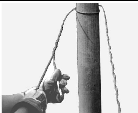
2. Inicie, pela marca de cor, a aplicação de uma das pernas da alça preformada no cabo de aço.
