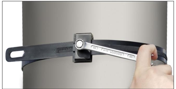
4. Assim que a tensão máxima for atingida, use uma chave catraca ou de boca para apertar o parafuso autoperfurante de aço inoxidável e concluir a instalação.
