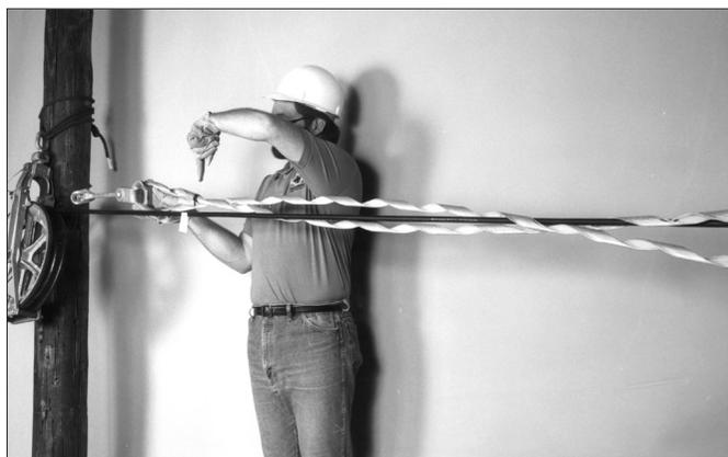
Figura 2 - Posicionamento da Alça Preformada.
