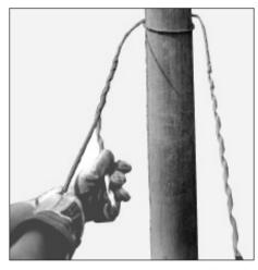
2. A partir de la marca de inicio de aplicación, aplique una de las piemas de la Retención Preformada en el cable de acero.
