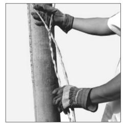
3. Haga coincidir la marca de color de la segunda pierna de la Retención Preformada con la primera y aplíquela hasta el final.
