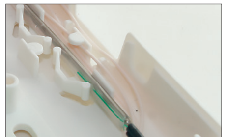
6. Hacer el empalme por fusión y acomode el protector termo contráctil en el compartimiento. Ejemplo salida Superior.
