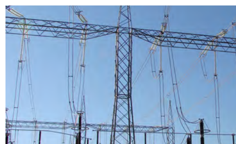
Cadeias instaladas ao Pórtico
