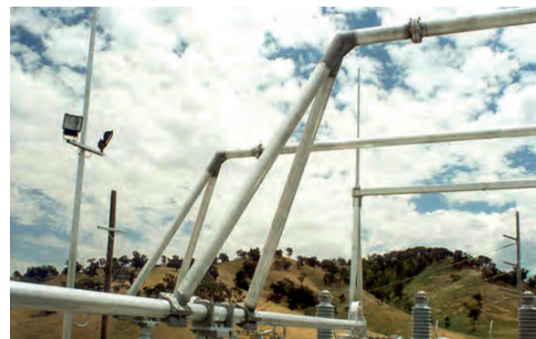
Sistema de Barramento Híbrido (Conectores Soldados e Aparafusados)
