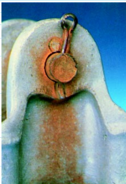
Dano em grampo de suspensão causado pela cupilha
