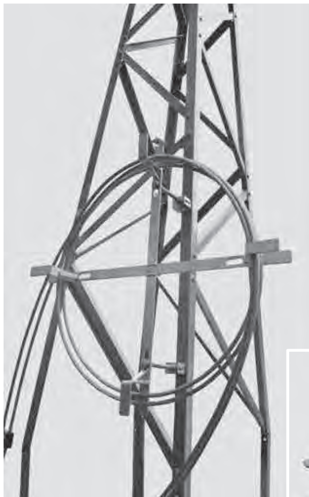
A fixação no montante da torre pode ser feita através de Suportes de Fixação à Compressão com Chapas em “L” ou com Garras.
