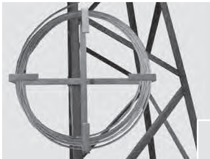
A fixação no montante ou na treliça da torre é feita através de um Suporte à Compressão com Chapas em “L”.
