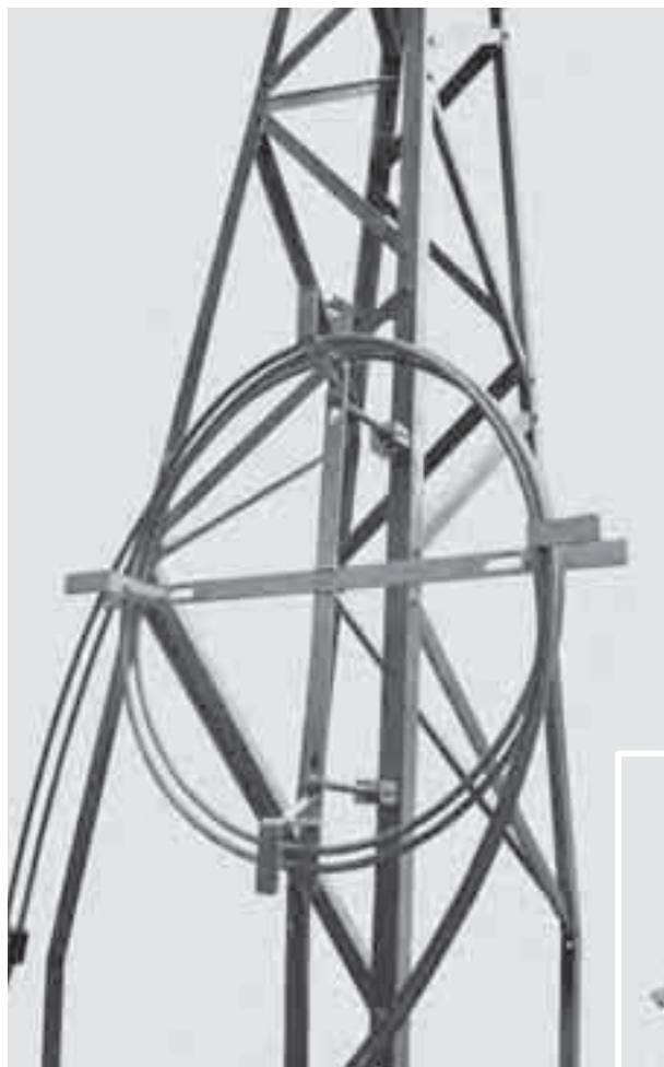
La fijación en el montante de la torre puede ser hecha a través de soportes de fijación a la compresión con chapas en "L" o con garras.
