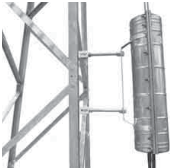
Con Soportes de Fijación Compresión con Garras.
