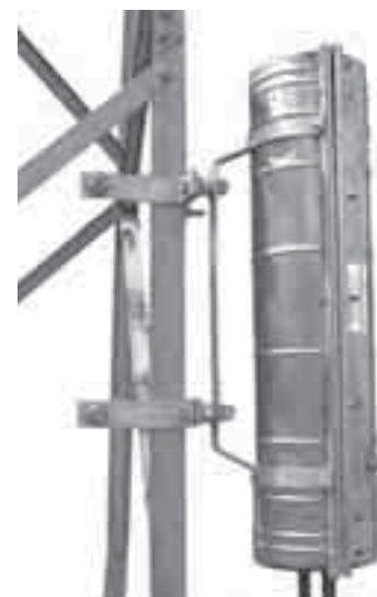
Con Soportes de Fijación a Compresión con Chapas en "L".
