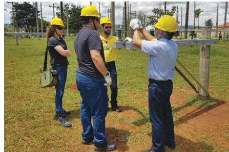
Carlos Cavalcante orientando equipe de engenharia da Cemig na instalação do novo Isolador.
