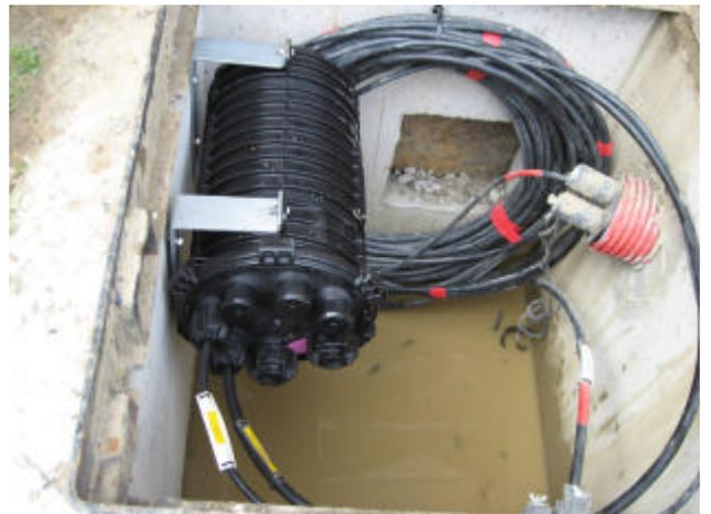
La caja FIBREGUARD™ se puede utilizar en cualquier tipo de instalaciones: en torres, en postes de madera o de cemento, colgadas directamente de un cable mensajero, en arquetas, en conductos o directamente enterradas, existiendo una gama de herrajes para cada aplicación. Asimismo puede ser instalada tanto como caja terminal, como de empalme, de segregación, en nodos primarios, secundarios, puntos finales de red, etc.
