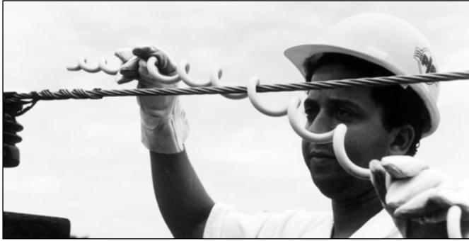
1. Posicione el SVD dejando la zona de agarre girada hacia el accesorio de fijación del cable (anclaje, suspensión ó amarre).
