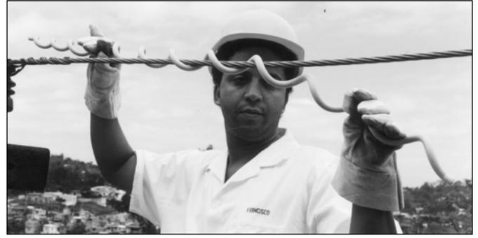
2. Inicie la aplicación del SVD en la dirección contraria al accesorio de fijación, tal como muestra la foto.
