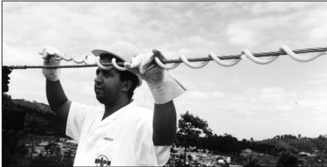
3. Aplique primero la zona de amortiguación del SVD, deslizando sobre el cable, de modo de dejar una distancia de 10 cm. entre el accesorio de fijación y el SVD.
