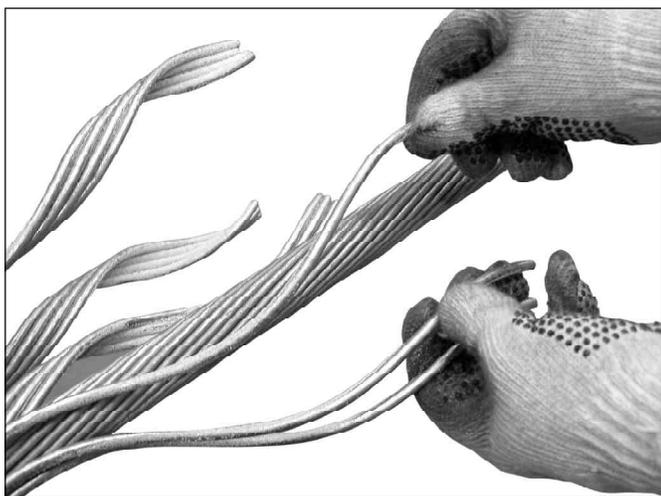
**7.** Para facilitar el final de la aplicación, separe las puntas de las varillas y aplíquelas una a una.
