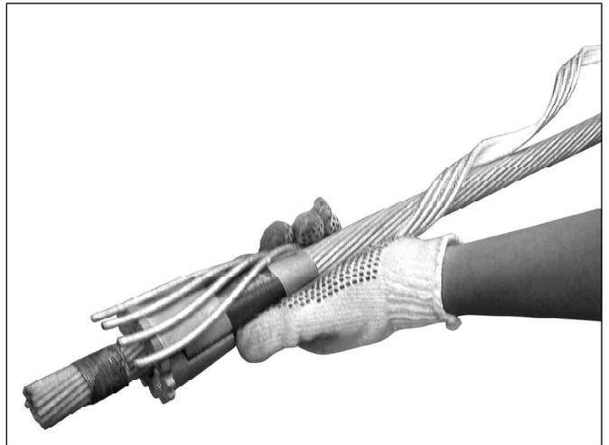
**4.** Inicie la aplicación del primer subconjunto de varillas preformadas. No aplique las varillas hasta el final.
