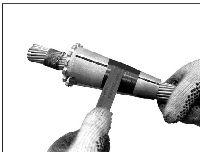
**2.** Posicione las cuñas de aluminio alrededor del cable y sujételas firmemente con una cinta adhesiva fina.
