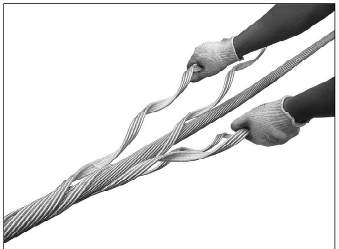
**6.** Finalice la aplicación de los subconjuntos de varillas simultáneamente, hasta faltar una o dos vueltas para completar la aplicación.
