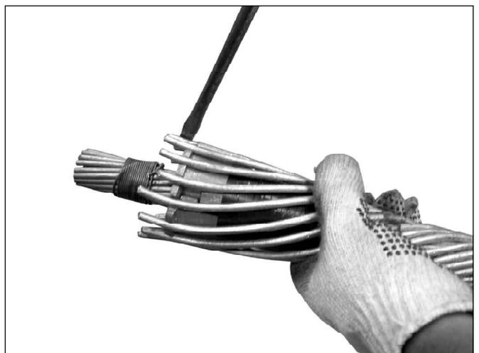
**8.** Concluida la aplicación de los subconjuntos de varillas preformadas, utilice un destornillador para colocar cada varilla en su correspondiente muesca de la cuña.
