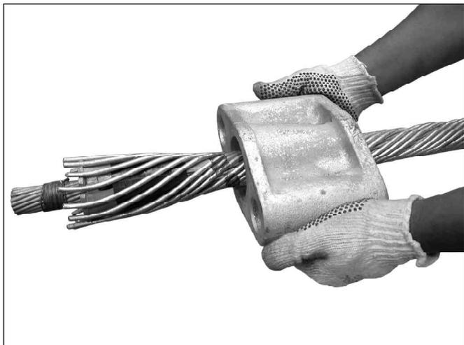
**9.** Verifique si las varillas están perfectamente encajadas en las muescas, en seguida, introduzca firmemente la cápsula sobre las varillas y cuñas.
