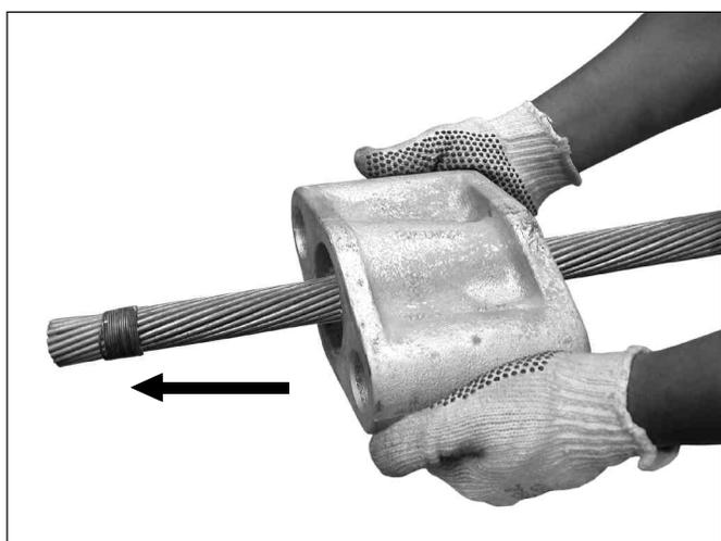
**1.** Introduzca la Cápsula en el cable, con el agujero central de mayor diámetro orientado hacia la extremidad del cable, según se muestra en la figura.
