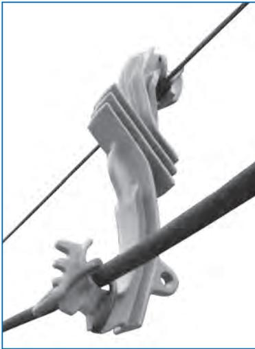
Accesorio de formato recto desarrollado especialmente para su utilización en líneas compactas rurales monofásicas clase 15kV. Colgado de un cable mensajero, su función es la sustentación del cable protegido de fase a lo largo del vano, manteniendo la aislación eléctrica de la línea.
