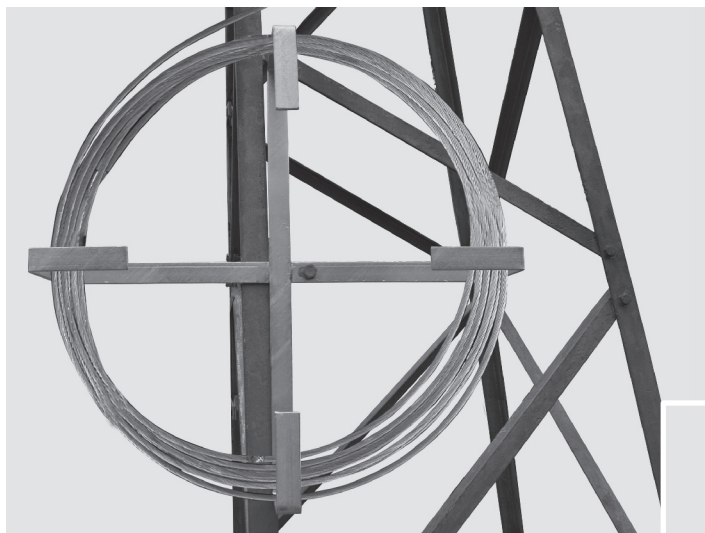
La fijación en el montante o en la rejilla de la torre se realiza a través de un soporte a la compresión con chapas en "L".
