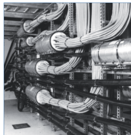
Caixa de Emenda de Galeria, consulte a PLP.
