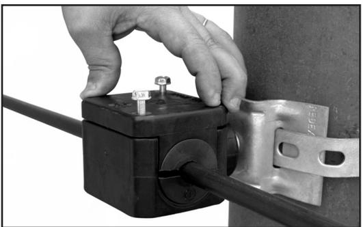
Foto 6 – Colocando a tampa no corpo do FDS.
