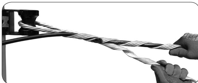
4. Faça coincidir a marca colorida da segunda perna da Alça Preformada com a da primeira e aplique-a sobre o cabo.
