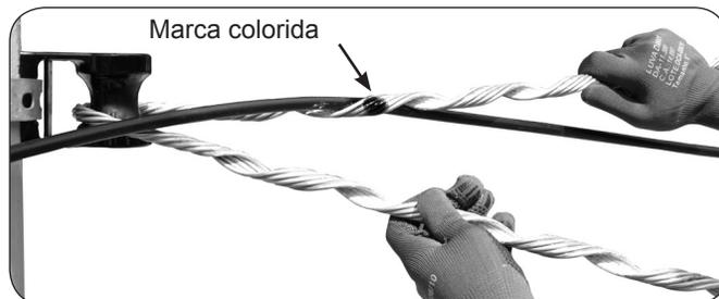
3. Tracione o cabo e a partir da marca colorida aplique uma das pernas da Alça Preformada sobre o cabo.
