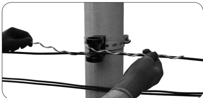
1. Introduza o Laço Preformado no SIPA e posicione o condutor entre as pernas do Laço. Puxe as pernas do Laço em direções opostas e aplique primeiramente uma das pernas do Laço sobre o cabo.
