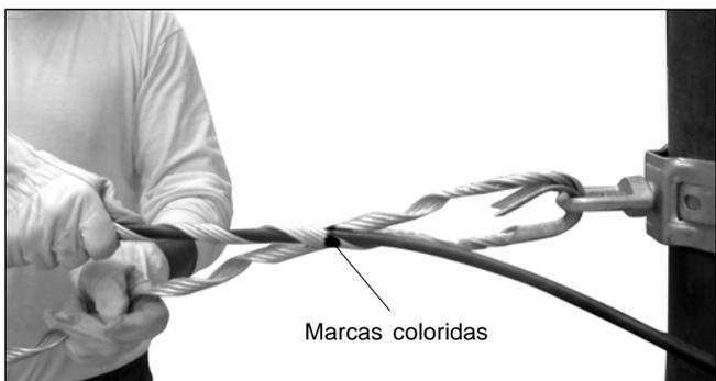
5. Faça coincidir a marca colorida da segunda perna da Alça Preformada com a da primeira e aplique-a sobre o cabo.
