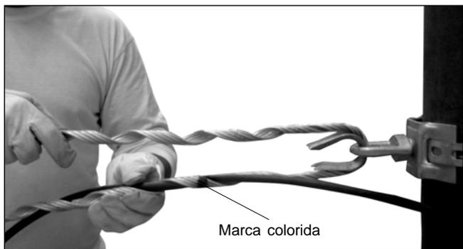
3. Tracione o cabo e, a partir da marca colorida, inicie a aplicação de uma das pernas da Alça Preformada sobre o cabo.
