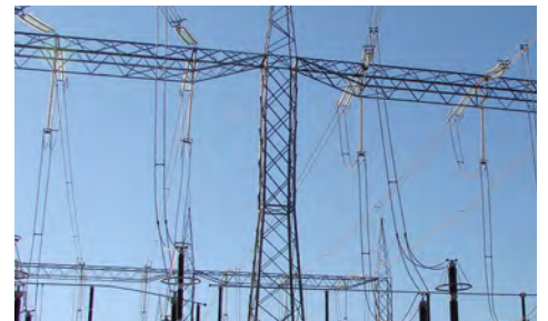
Cadeias instaladas ao Pórtico
