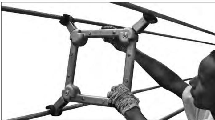
1. Posicione o Corpo do Espaçador nos condutores, conforme mostra a foto.
