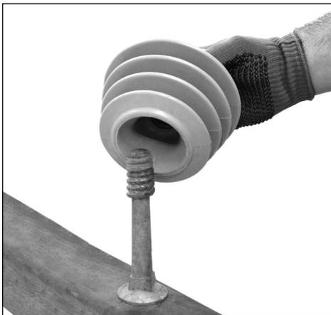
**1.1** Instale o parafuso pino na cruzeta seguindo os procedimentos da sua companhia e, em seguida, aplique o Isolador Polimérico no parafuso.
