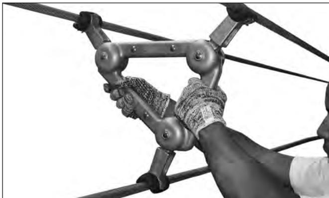
**1.** Posicione o Corpo do Espaçador nos condutores, conforme mostra a foto.
