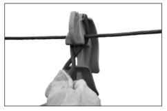
**1.3** Iniciando a aplicação pelo cabo mensageiro, dê um giro no Anel, estique e posicione a sua extremidade na ranhura localizada na garra do Separador.
