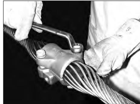
**6.** Posicione o corpo inferior e superior do Grampo sobre as Varetas Preformadas e insira os parafusos com as arruelas de pressão. Aperte até que as arruelas de pressão fiquem planas.
