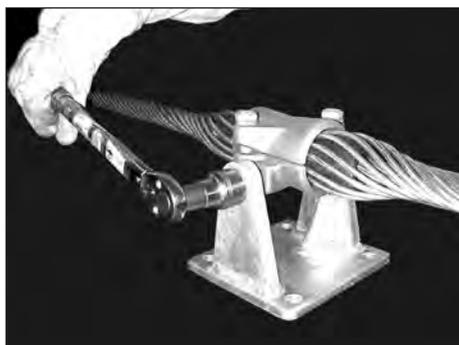
**9.** Alinhe o parafuso com o furo do Grampo e aplique um torque de 7,6 kgf.m.
