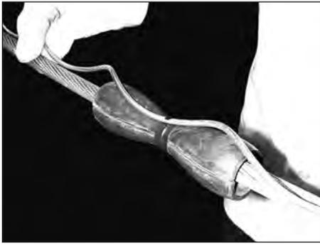
**3.** Inicie a aplicação das Varetas Preformadas colocando a marca central das mesmas sobre o meio do coxim. Mantendo a Vareta em posição paralela ao cabo, inicie o giro de uma das extremidades em torno do cabo.
