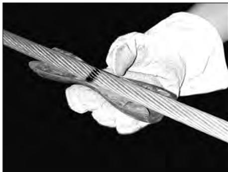
**1.** Assinale a posição correta do Grampo sobre o cabo condutor utilizando fita ou tinta e posicione os Coxins sobre a marca indicada. Deixe espaço livre para o trabalho sobre o cabo.
