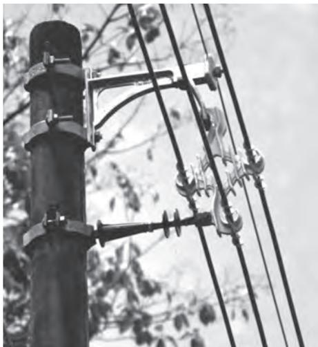
Acessório de material polimérico cuja função é a fixação do espaçador losangular, evitando-se a aproximação ou o afastamento dos cabos cobertos junto às estruturas e reduzindo-se, assim, a vibração mecânica das redes compactas classes de tensão 15 e 35 kV.
